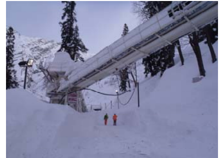
Bild: Tunnel-Spreng-Vortriebsmaschine mit Powerflex 753, 755 FU-Antrieben im indischen Himalaya Gebirge (3000müM)-Tunnelbau unter Extrembedingungen.
