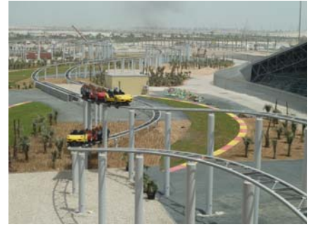
Bild: Parallel- Linear- Antriebs- Roller-Coaster in Abu Dhabi (Emirates). Beratung, Installations- und Inbetriebnahmeleitung Elektrotechnik.
