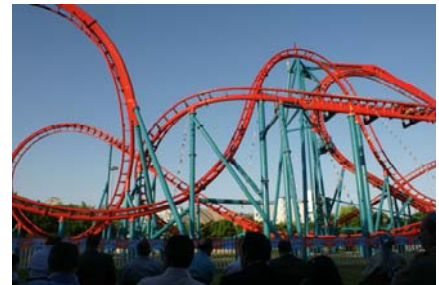
Bild: Gesamtprojektleitung Elektrotechnik für einen Roller Coaster in DreamCity (Irak).
